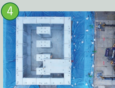
据付状況全景
