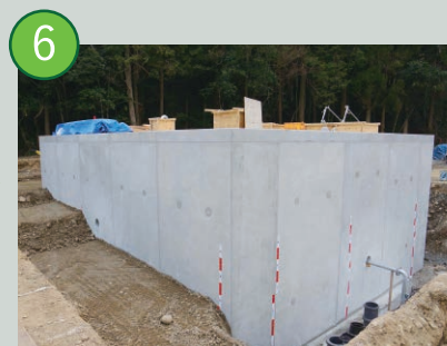
埋め戻し状況
